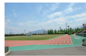
米子市営東山陸上競技場
